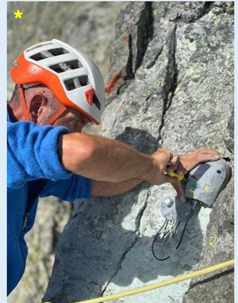
Due guide alpine al lavoro allo Spigolo Murari della Bessanese: Stefano Pelissero installa una «Pera» (Foto Andrea Carelli, 06/08/2024)
